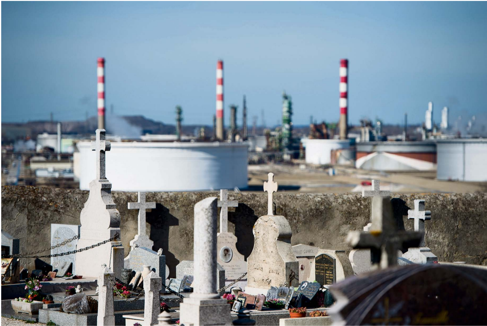
Vue sur le complexe pétrochimique du golfe de Fos-sur-Mer depuis le cimetière du village.
